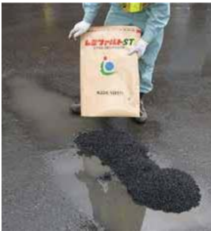
■ 雨天直後の施工
